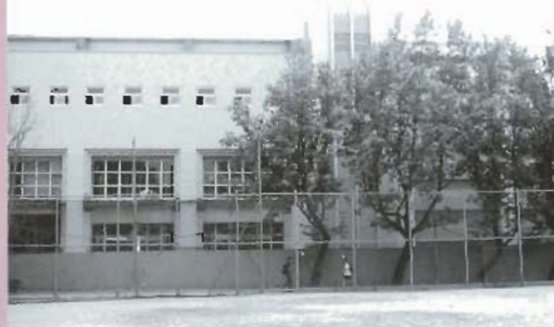
● 體育館的部份已近完成，將成為醫學綜合大樓服務師生的首要區域。
